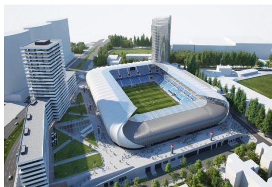
National Football Stadium, Słowacja, systemy wentylacji
