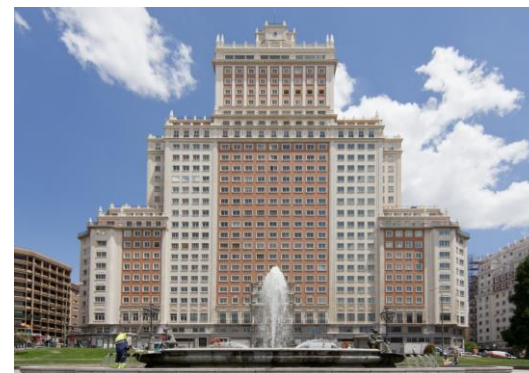
Riu Hotel, Madryt, Hiszpania, ogniochronne zabezpieczenia konstrukcji
