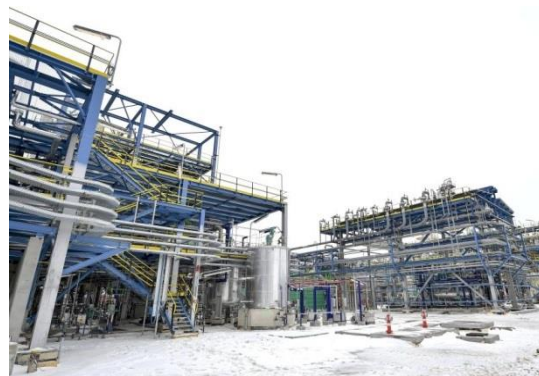
Fabryka kauczuku w Tiszaújváros, Węgry - ogniochronne zabezpieczenia konstrukcji
