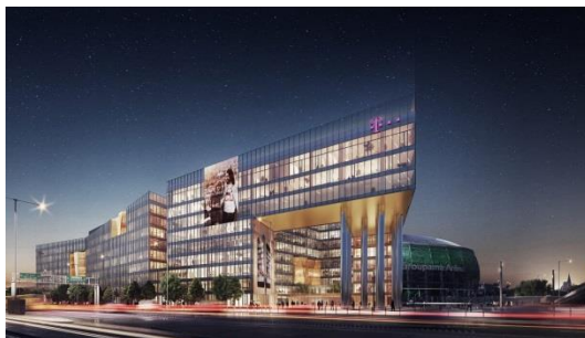
Telekom – siedziba główna, Budapeszt, Węgry; systemy wentylacji mechanicznej
