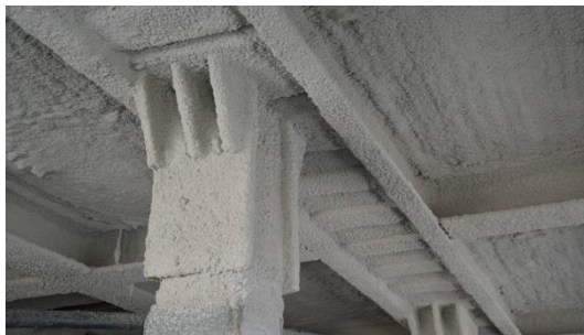
Hotel Riu Plaza España, Hiszpania, ogniochronne zabezpieczenia konstrukcji
