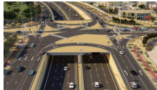
Al Rayyan Road Tunnel, Katar, Doha, ogniochronne zabezpieczenia konstrukcji
