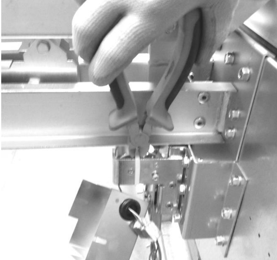
Rys. 37 Przecinanie opaski zaciskowej w celu odbezpieczenia zamka.
