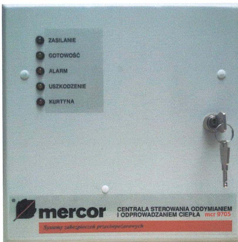
Rys. 2. Sygnalizacja wspólna na stronie czołowej drzwi w wykonaniu dla kurtyn dymowych lub przeciwpożarowych
